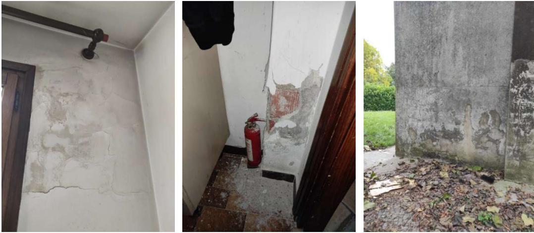
Interno: Sala da pranzo e C.T. – Esterno: prospetto nord
