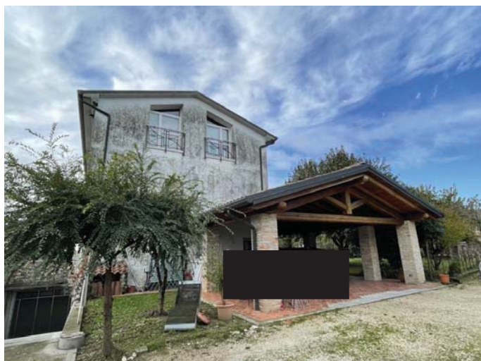
foto 1 vista facciata nord
