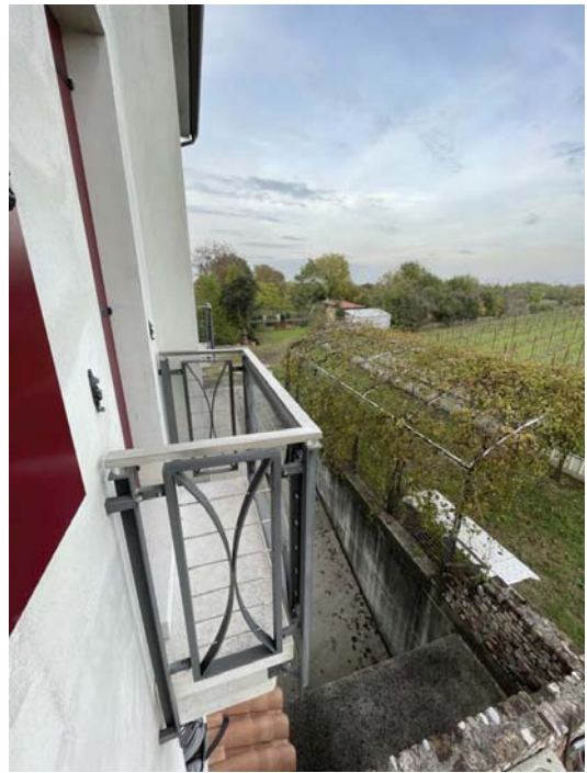
foto 30 particolare balcone - lato est (P1°)
