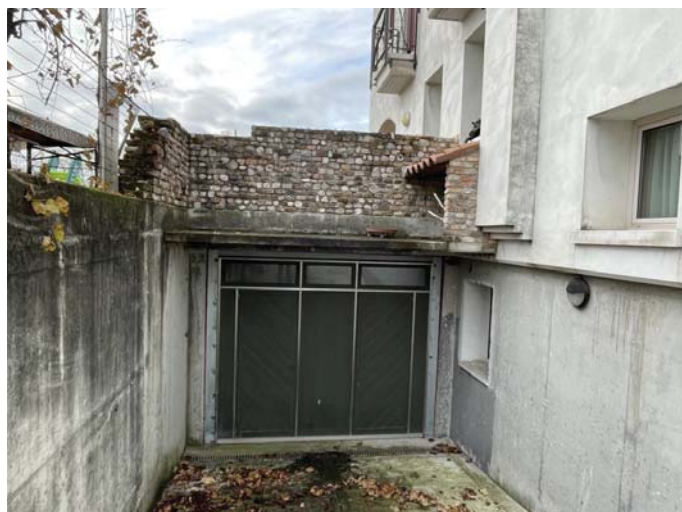
foto 2 vista vs garage
