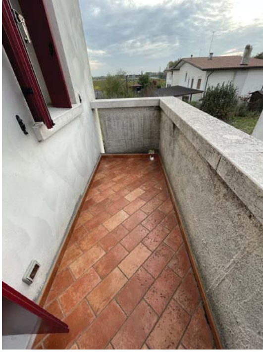
foto 35 terrazza su facciata ovest (P1°)
