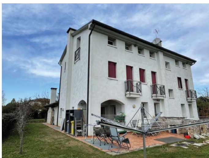
foto 5 vista facciate sud-est
