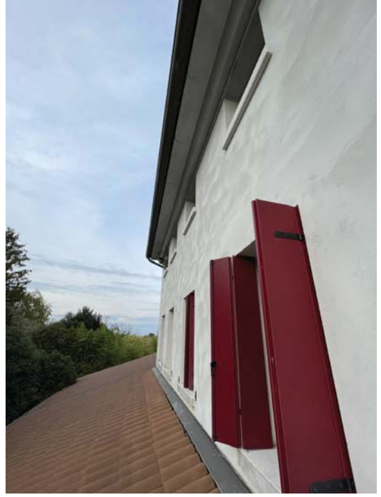
foto 36 porzione facciata ovest da terrazza (P1°)
