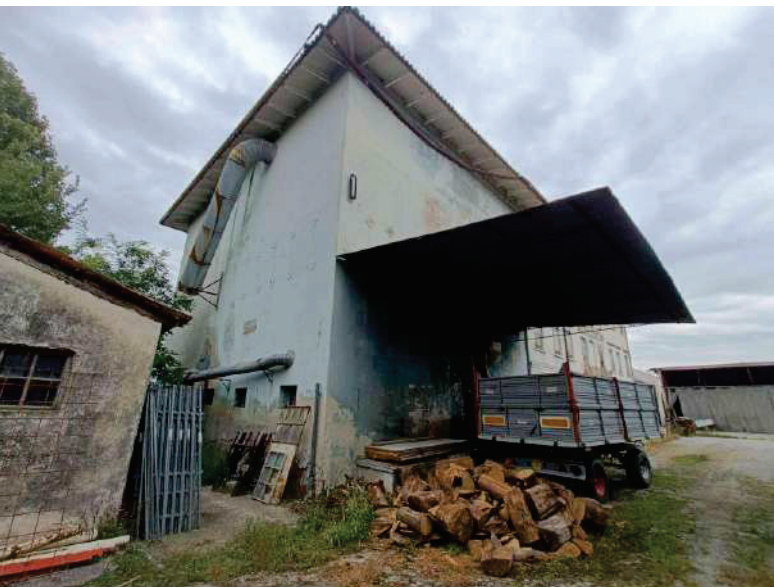
F03: Lotto1 - mulino prospetto sud est
