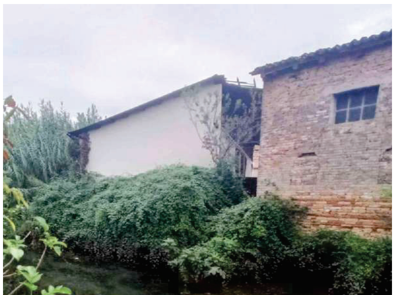
F42: Lotto1 – magazzino nord prospetto ovest
