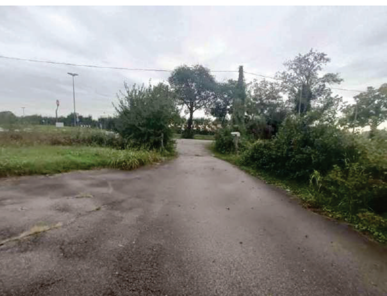
F45: Lotto1 – viabilità interna
