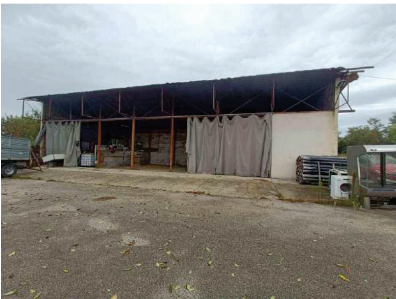
F37: Lotto1 – magazzino nord prospetto sud
