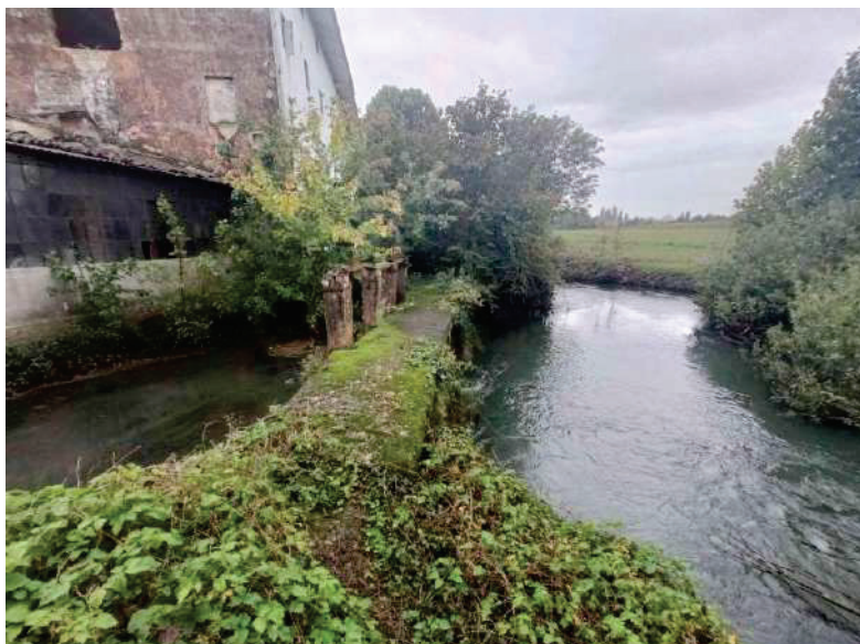
F87: Lotto 3 – passerella opera di presa
