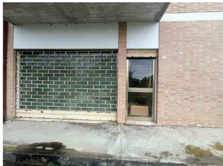
F58: Lotto 2 – dettaglio facciata sud
