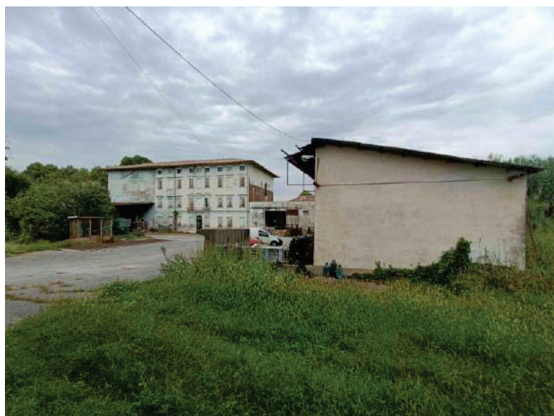
F38: Lotto1 – magazzino nord prospetto est
