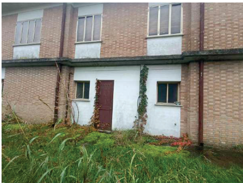
F59: Lotto 2 - prospetto nord accesso esterno a ct
