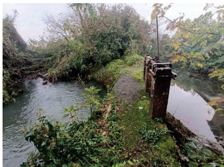
F88: Lotto 3 - passerella opera di presa
