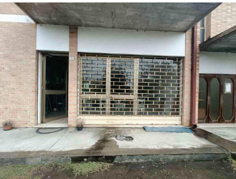
F57: Lotto 2 – dettaglio facciata sud
