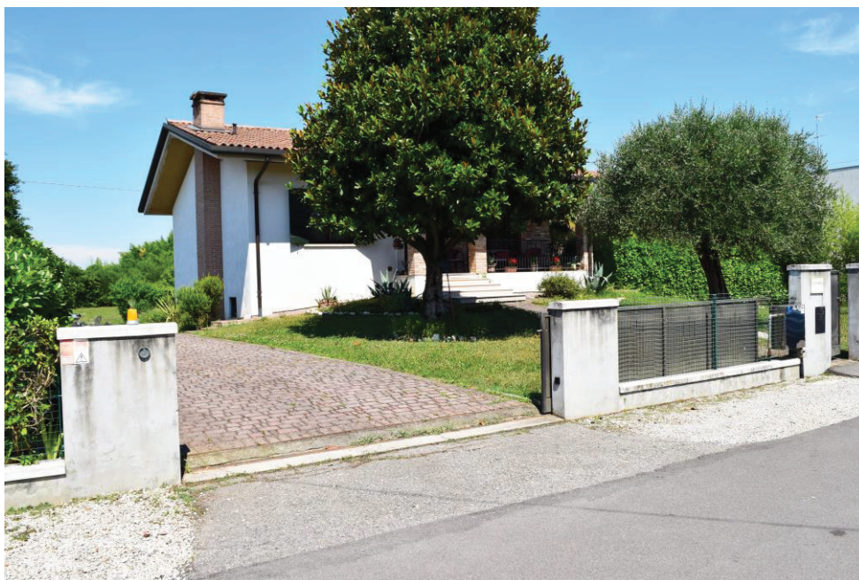
Foto 02: Vista accesso carraio ed accesso pedonale
