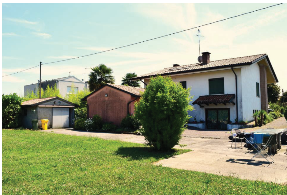
Foto 03: Vista edificio lato nord-ovest
