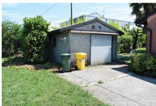
Foto 39 Magazzino annesso da demolire
