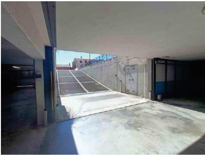
F39: P interrato rampa
