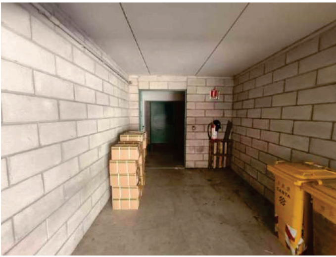
F37: P interrato corridoio comune
