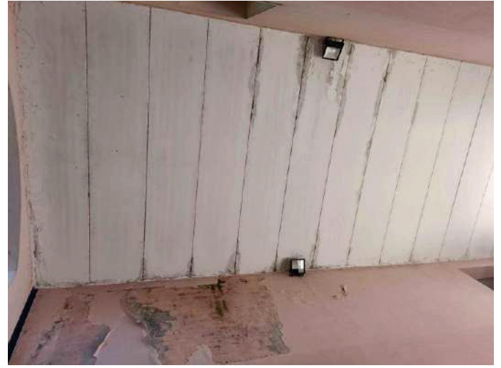
F40: PT soffitto portico
