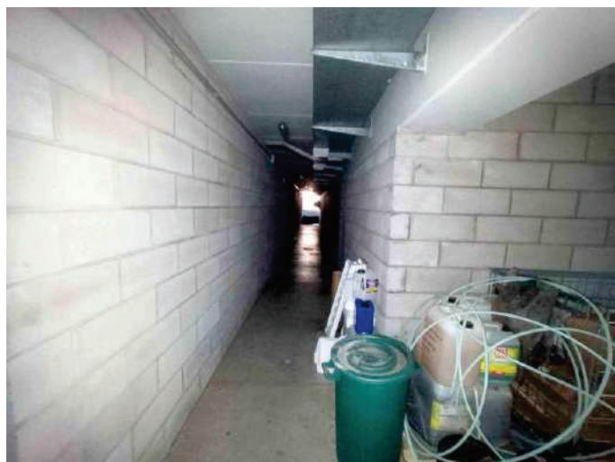
F36: P interrato corridoio comune
